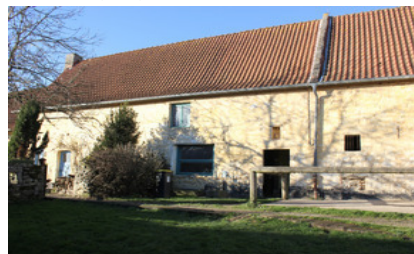
20. Pignon ouest maçonné (voir 2)
