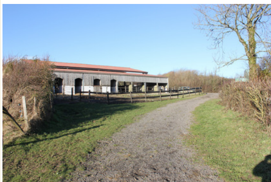
32. Vue depuis l'ancien parking des boxes accolés
