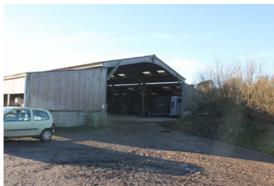
33. Accès depuis le parking principal d'accueil
