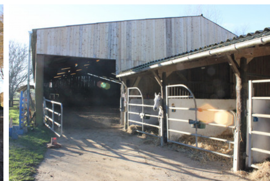
27. Boxes plus récents. Structure bois épaisses
